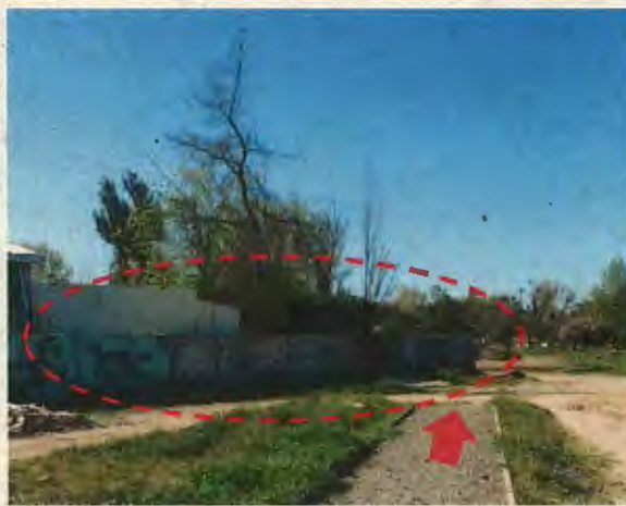
Fotografía N° 6 - 22/09/16: Vista de paseo peatonal en ejecución discontinua en calle 7 Sur, entre 1 y 2 Oriente, en dirección Poniente-Oriente, se muestra la misma propiedad que no ha sido expropiada.
