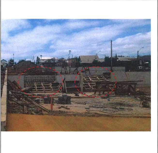
Fotografía N° 20 - 14/01/16: Vista de escalera en ejecución en sector de explanada de acceso de acuerdo a lámina 3 de 5, del Proyecto de Estructuras.
