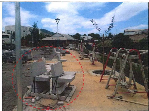
Fotografía N° 2 - 14/01/16: Vista de "Esaños 230x57x45" sin instalar de acuerdo a la solución graficada en la lámina ARQ-02, del Proyecto de Arquitectura.
