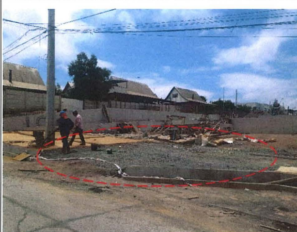
Fotografía N° 11 - 14/01/16: Vista de "Vereda HCV e=0,07 m (Color Ocre)" vereda norte de la calle Alcalde Alamiro Díaz de acuerdo a lámina 3 de 9, del Proyecto de Pavimentación.
