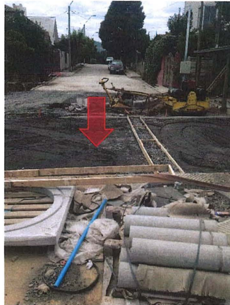
Fotografía N° 10 - 14/01/16: Detalle de ejecución de "Carpeta HCV e=0,15 m (Color Ocre)" de acuerdo a lámina 3 de 9, del Proyecto de Pavimentación.
