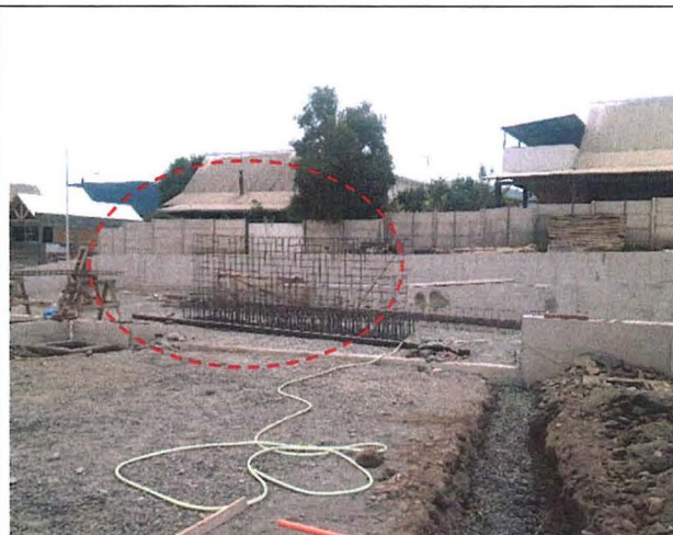
Fotografía N° 22 - 14/01/16: Vista de ejecución de enfierradura de muro de contención eje "C" entre los tramos "3" y "4" en ejecución de acuerdo a lámina 3 de 5, Proyecto de Estructuras.
