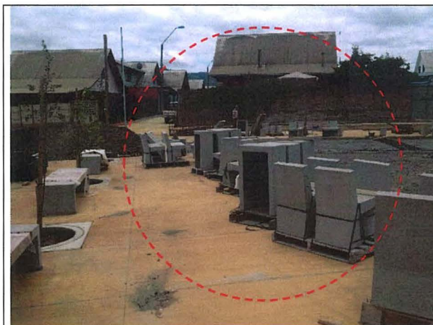
Fotografía N° 1 - 14/01/16: Vista de "Esaños 230x57x45" sin instalar de acuerdo a la solución graficada en la lámina ARQ-02, del Proyecto de Arquitectura.
