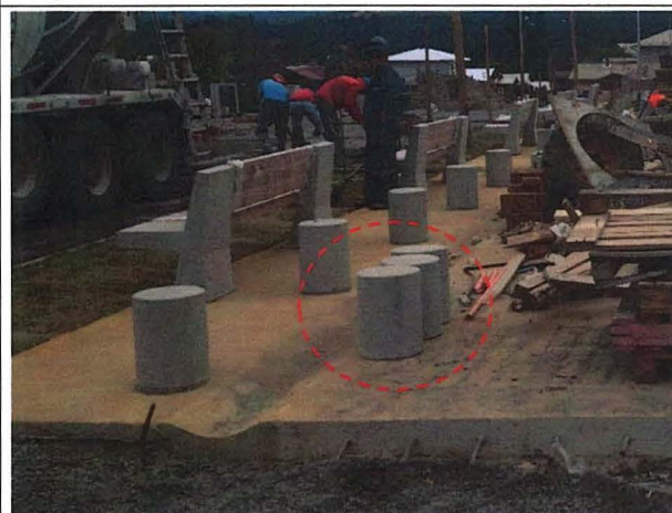
Fotografía N° 1 - 14/01/16: Vista de "Esaños 230x57x45" sin instalar de acuerdo a la solución graficada en la lámina ARQ-02, del Proyecto de Arquitectura.
