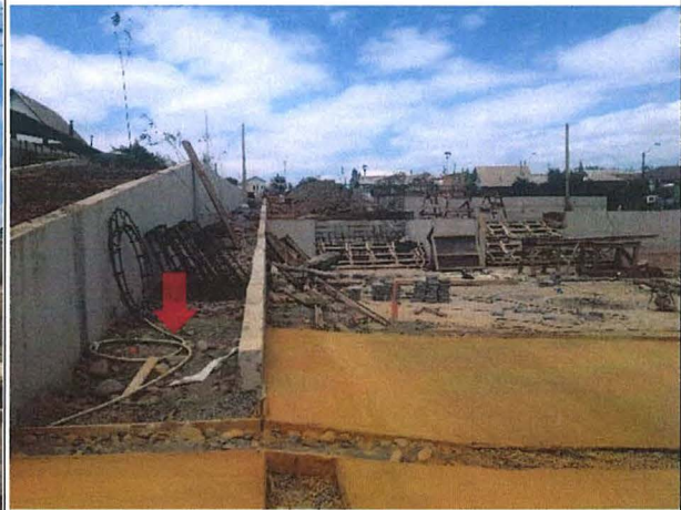
Fotografía N° 12 - 14/01/16: Vista de "Vereda HCV e=0,07 m (Color Ocre)" rampa explanada de acceso de acuerdo a lámina 3 de 9, del Proyecto de Pavimentación.
