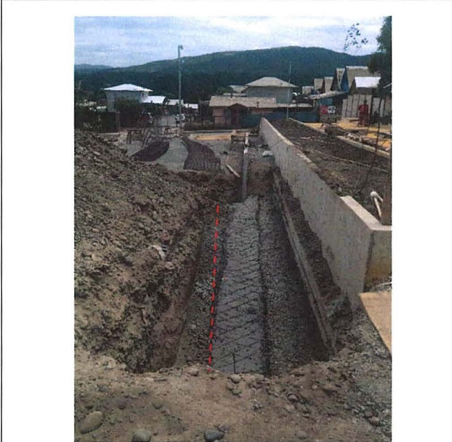
Fotografía N° 19 - 14/01/16: Vista de muro de contención del eje "C", entre los tramos "3" y "4" en ejecución según lámina 3 de 5, del Proyecto de Estructuras.
