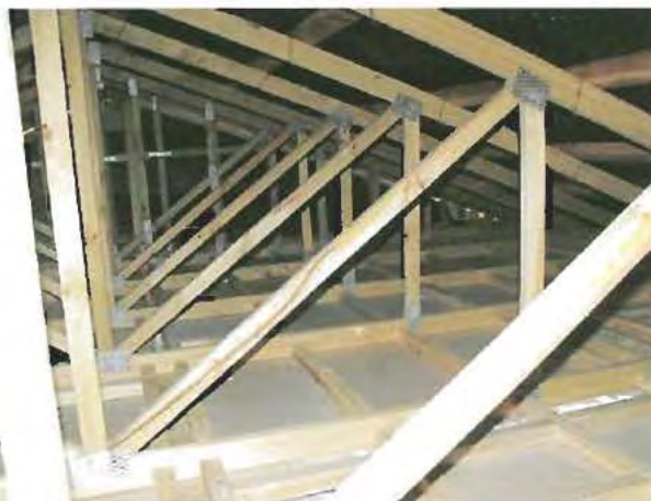
Fotografía N° 71: Detalle y vista del complejo de techumbre de la vivienda sin aislación térmica.
