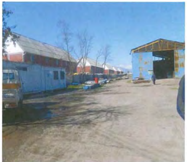
Foto N° 10 Otra vista, donde se aprecia el terreno ocupado con instalaciones de otra empresa
