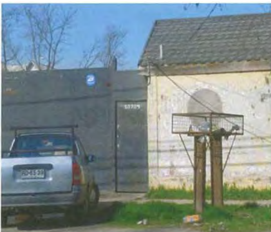
Foto N° 11 Empresa industrial con bodegas y edificaciones, al 30/08/11
