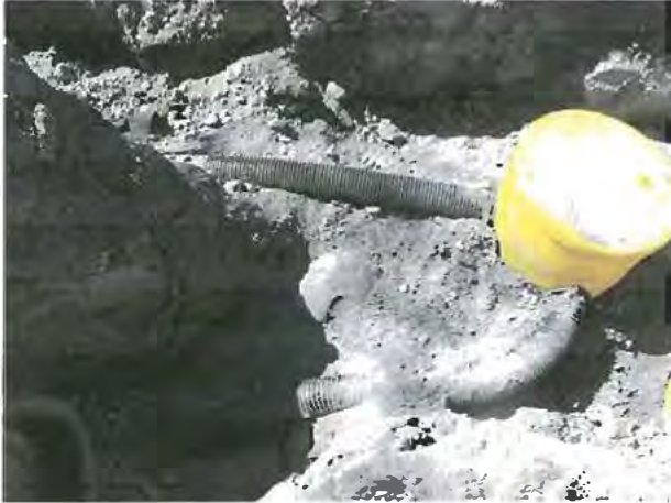
Fotografía N° 56: Vista del material fino utilizado como relleno del sistema de drenes.
