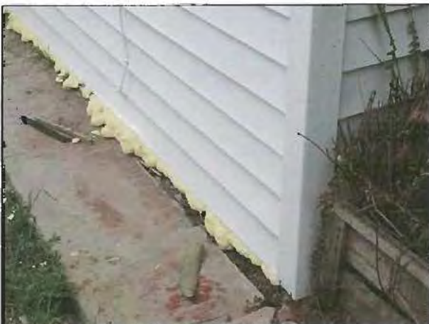
Fotografía N° 96: Detalle del exceso de sello expansivo colocado en la zona inferior del tabique perimetral.
