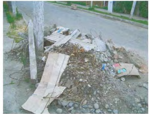
Foto N° 87 No se retiraron los escombros, calle [redacted]
