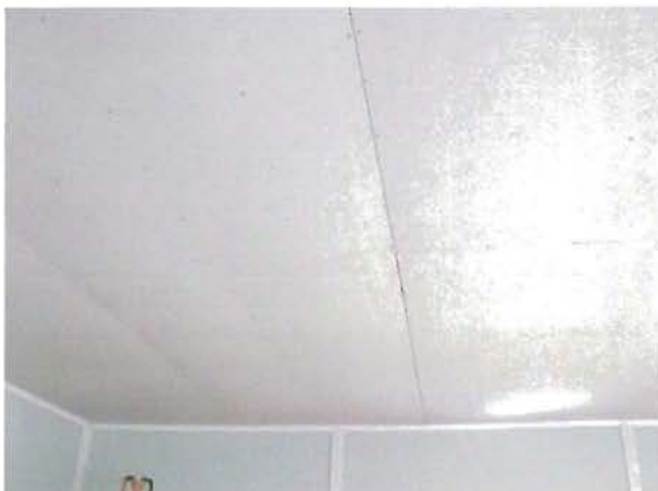
Fotografía N° 62: Vista de las ondulaciones en las planchas instaladas en cielos de las viviendas.
