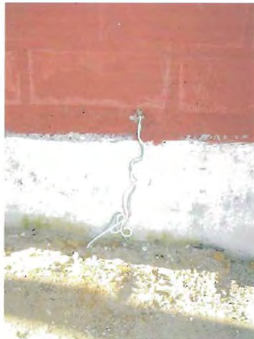
Fotografía N° 53: Vista del cableado de la puesta a tierra de Servicio de las viviendas.
