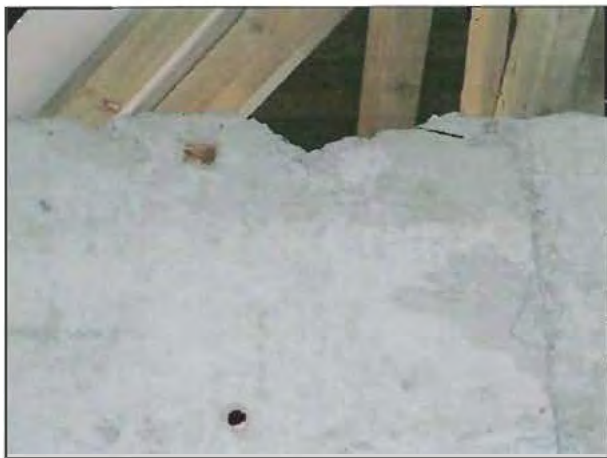
Fotografía N° 19: Desprendimiento en cadena de hormigón bajo la estructura de techumbre.
