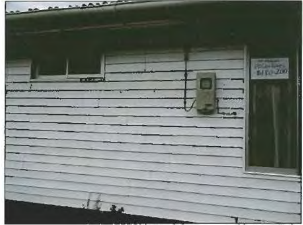
Fotografía N° 94: Elevación que registra el término de cada pieza de siding
