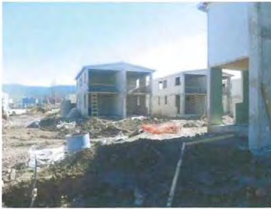
Foto N° 1 Avance de las obras
