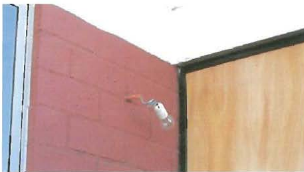
Fotografía N° 52: Vista de los portalámparas instalados en los accesos de las viviendas.
