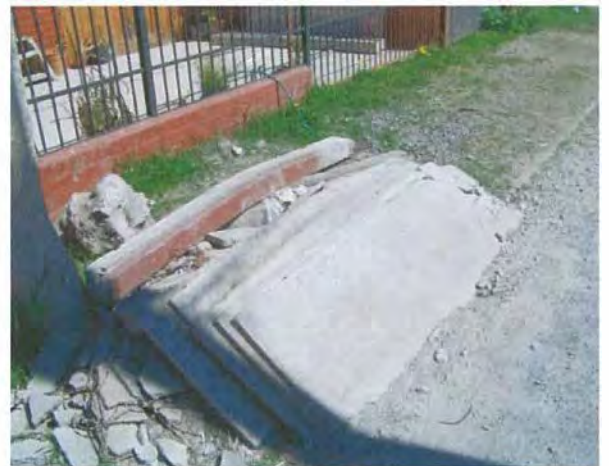
Foto N° 89 No se retiraron los escombros, calle [redacted]
