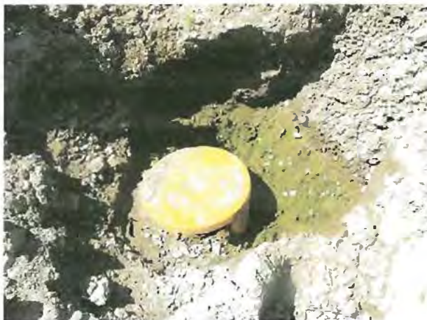
Fotografía N° 54: Detalle de filtraciones en cámaras del sistema de alcantarillado.
