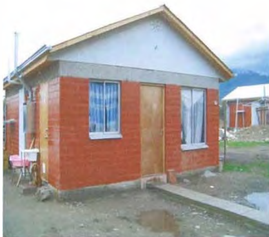
Foto N° 43 El proyecto contempla la construcción de 30 viviendas de 42,05 m 2
