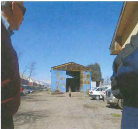
Foto N° 9 Al 30/08/11, obra no iniciada y terreno ocupado por otra empresa
