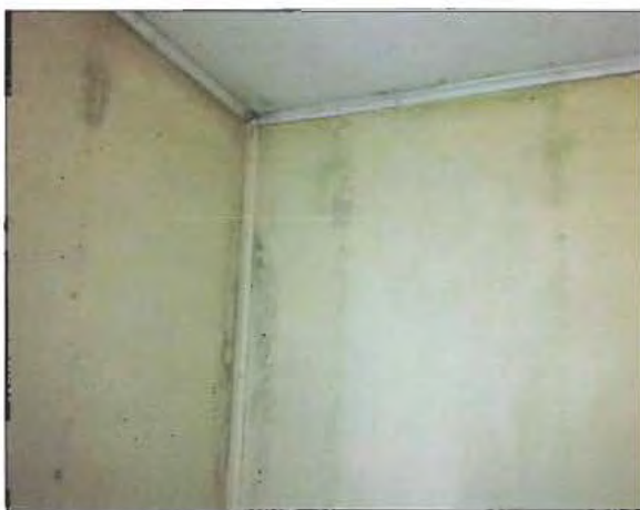
Fotografía N° 31: Vista de la aparición de hongos en los paneles interiores de la vivienda.
