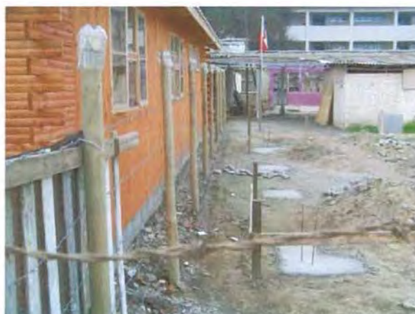
Foto N° 46 Distanciamientos inferior a 1,40m, hacia el límite predial. Vivienda ubicada en calle [REDACTED]
