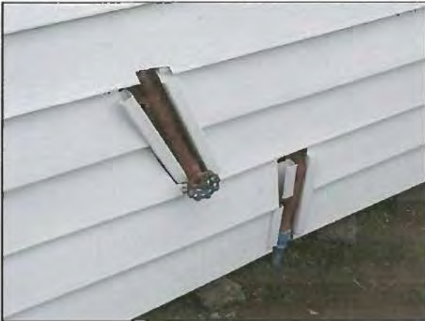
Fotografía N° 95: Detalle de la terminación ejecutada por el contratista para dar paso a la llave de corte y tuberías de la red de agua potable de una vivienda beneficiada.
