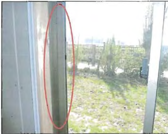
Fotografía N° 37: Detalle de la hoja de corredera desprovista de la quincallería necesaria para la apertura marcada con círculo.
