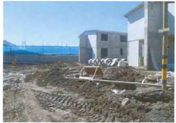
Foto N° 2 Otra vista del avance de las obras
