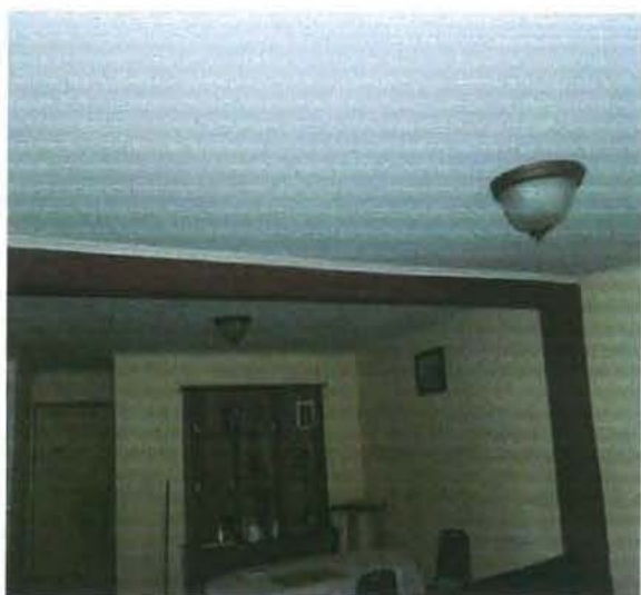
Foto N° 103 Trabajos diferentes a los presupuestados, vivienda de [REDACTED]
