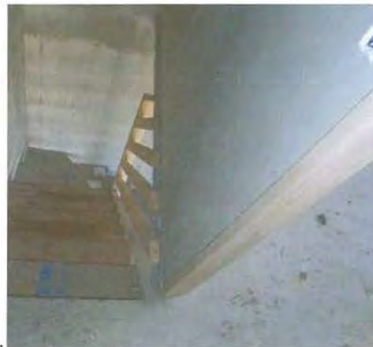
Foto N° 3 Barandas de madera, escalas interiores
