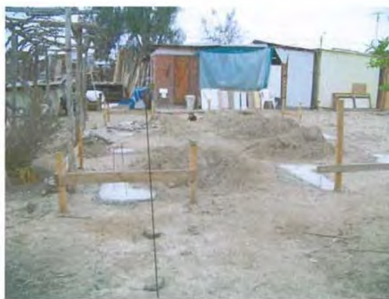
Foto N° 64 Fundaciones sobre predio vecino, calle
