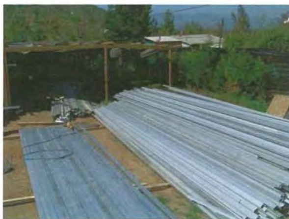
Foto N° 66 Materiales acopiados a la interperie
