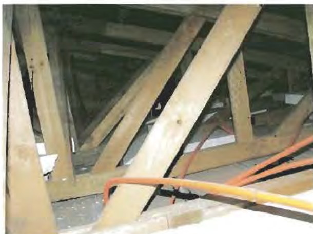
Fotografía N° 58: Vista del entretecho de la vivienda y la instalación de la aislación térmica.
