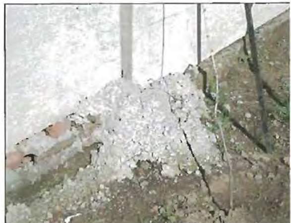
Fotografía N° 74: Detalle de la fundación desparramada de un pilar del muro tipo pandereta.
