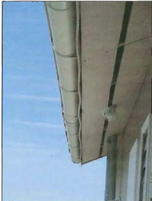
Fotografía N° 38: Detalle del tapacán ondulado.
