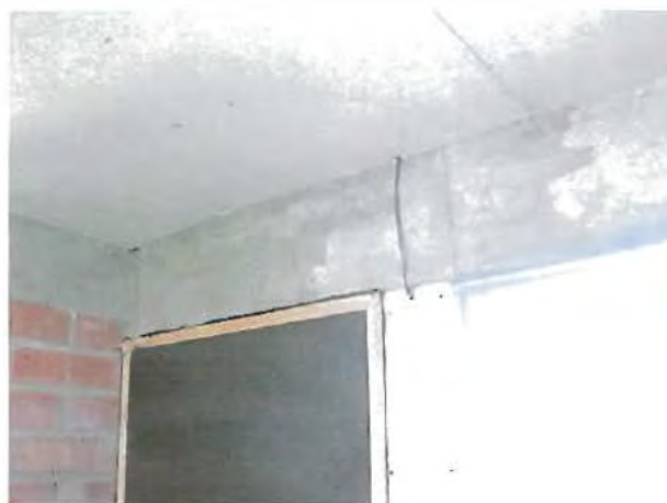
Fotografía N° 13: Vista de la instalación eléctrica y cableado en la vivienda.
