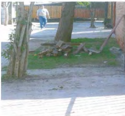
Foto N° 100 Falta retiro de escombros
